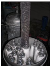
Abb. 17: Schmutzfilter + AGXX-Module: (a) Druckfilter/Filterkerzen, (b) und (c) AGXX-Module SKT + Magnet- und Bandfilter
