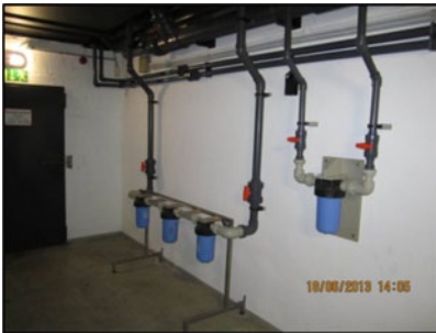
Abb. 16: Einbindung von AGXX-Mikrobenfiltern in VE-Wasserversorgungsleitungen
